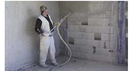
Das Aufbringen des Innenputzes
