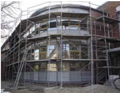
Durch das Gerüst lässt sich die Außenfassade erahnen
