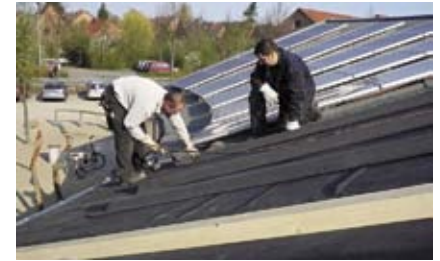
Dachdecker montieren die Konsolen für die Photovoltaikanlage
